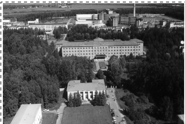
Рис. 1. Общий вид Петербургского института ядерной физики
